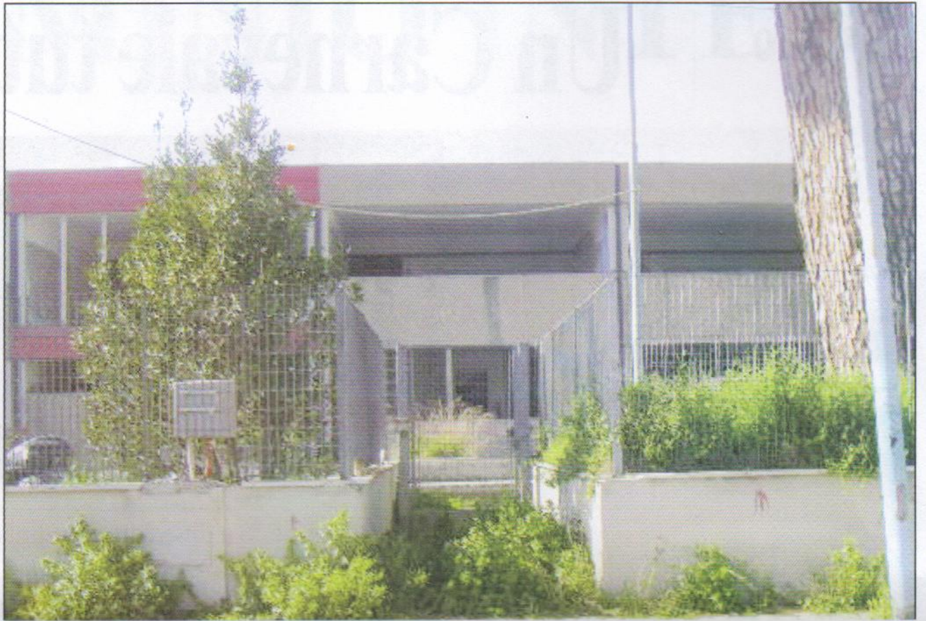
L'edificio, in fase di ristrutturazione, futura sede del nuovo istituto
